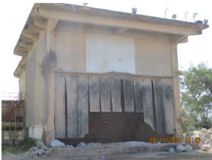
ภาพที่ 2-15 ม่านริวและระบบสเปรย์น้ำบริเวณโรงโม
