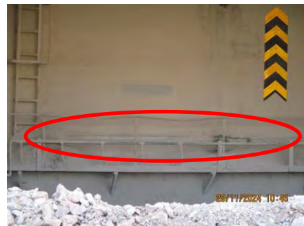
ภาพที่ 2-15 ม่านริวและระบบสเปรย์น้ำบริเวณโรงโม
